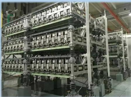
串联换流器:  $2 \times 60\text{MVA} @ 220\text{kV}$  晓庄-铁北双回线
